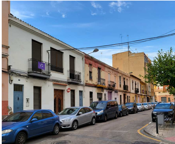
Viviendas en Calle Cami Vell de Xirivella
